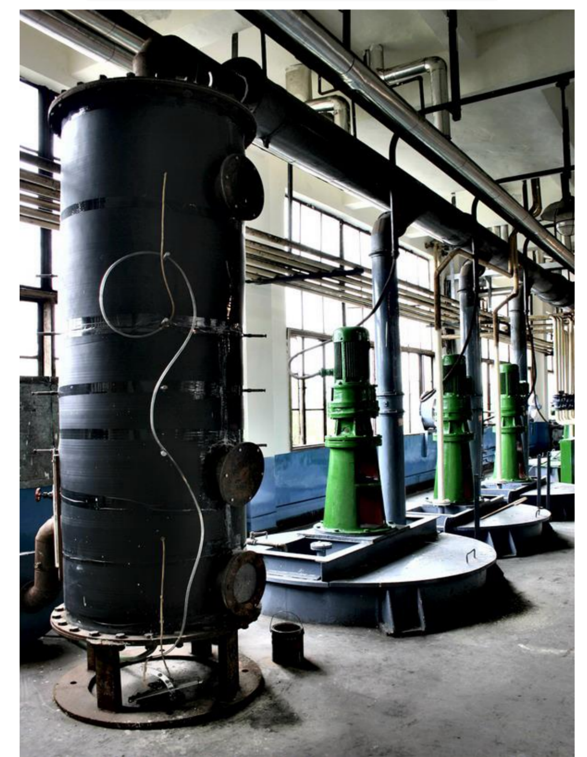
中试试验现场照片
